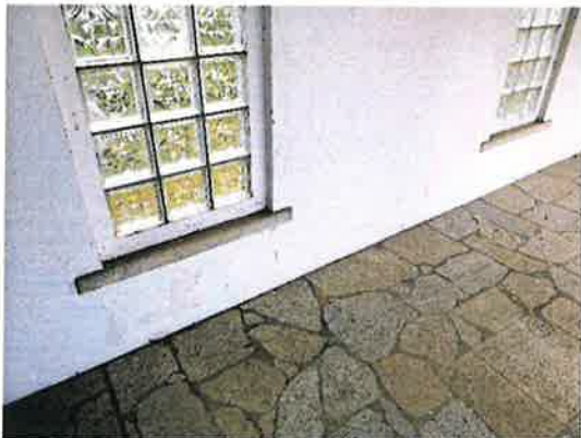
Présence d'humidité dans le mur
