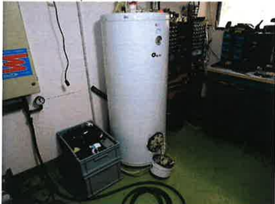
Boiler électrique d'eau chaude
