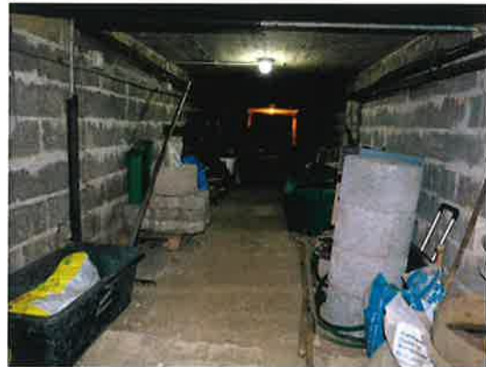
Canal de communication situé sous le couvert
