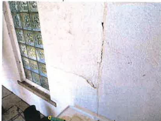
Présence d'humidité dans le mur
