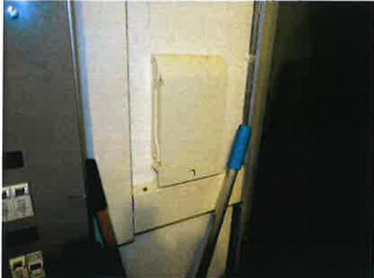
Coffret d'introduction de la fibre optique
