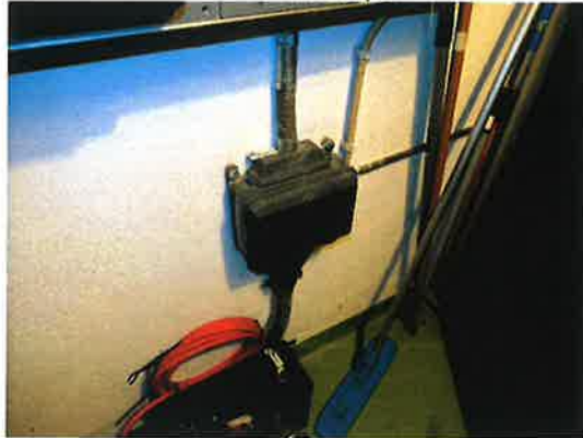
Coffret d'introduction de la fibre optique
