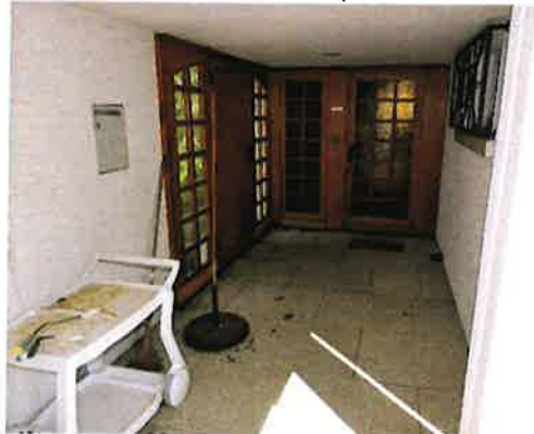
Couvert reliant les bâtisses, entrée
