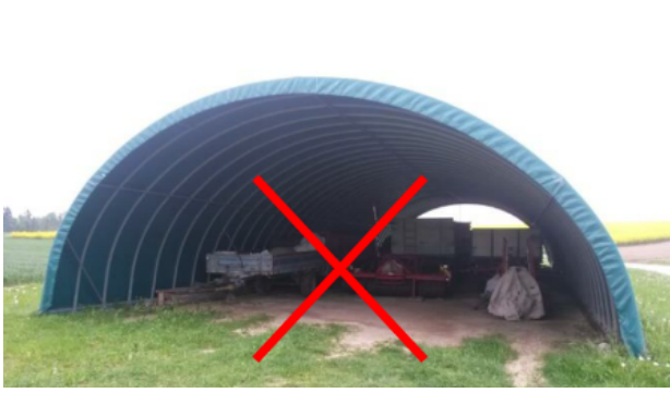
(a) Nicht erhobener Unterstand, keine Verankerung in Beton, Erdboden.
