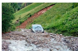
Im Juli 2020 verschüttete ein Murgang das Oberbachtal in Jaun. Quelle: AfU.
