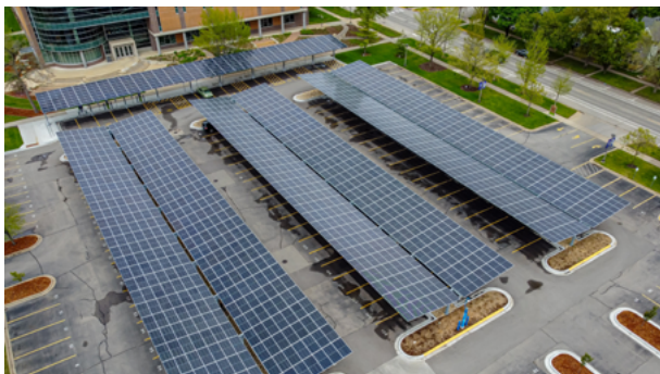
Photovoltaik-Carport, lizenzfreies Foto
