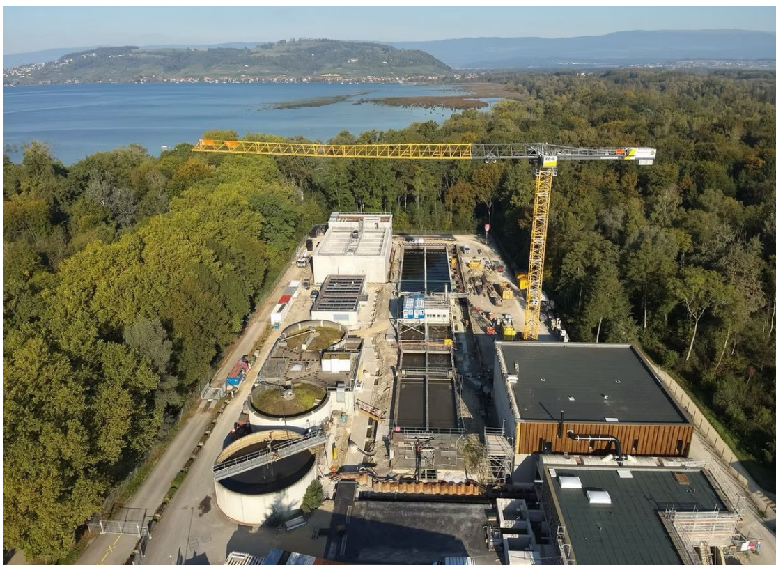
Extension de la STEP Seeland Süd à Muntelier. © ARA Seeland Süd
