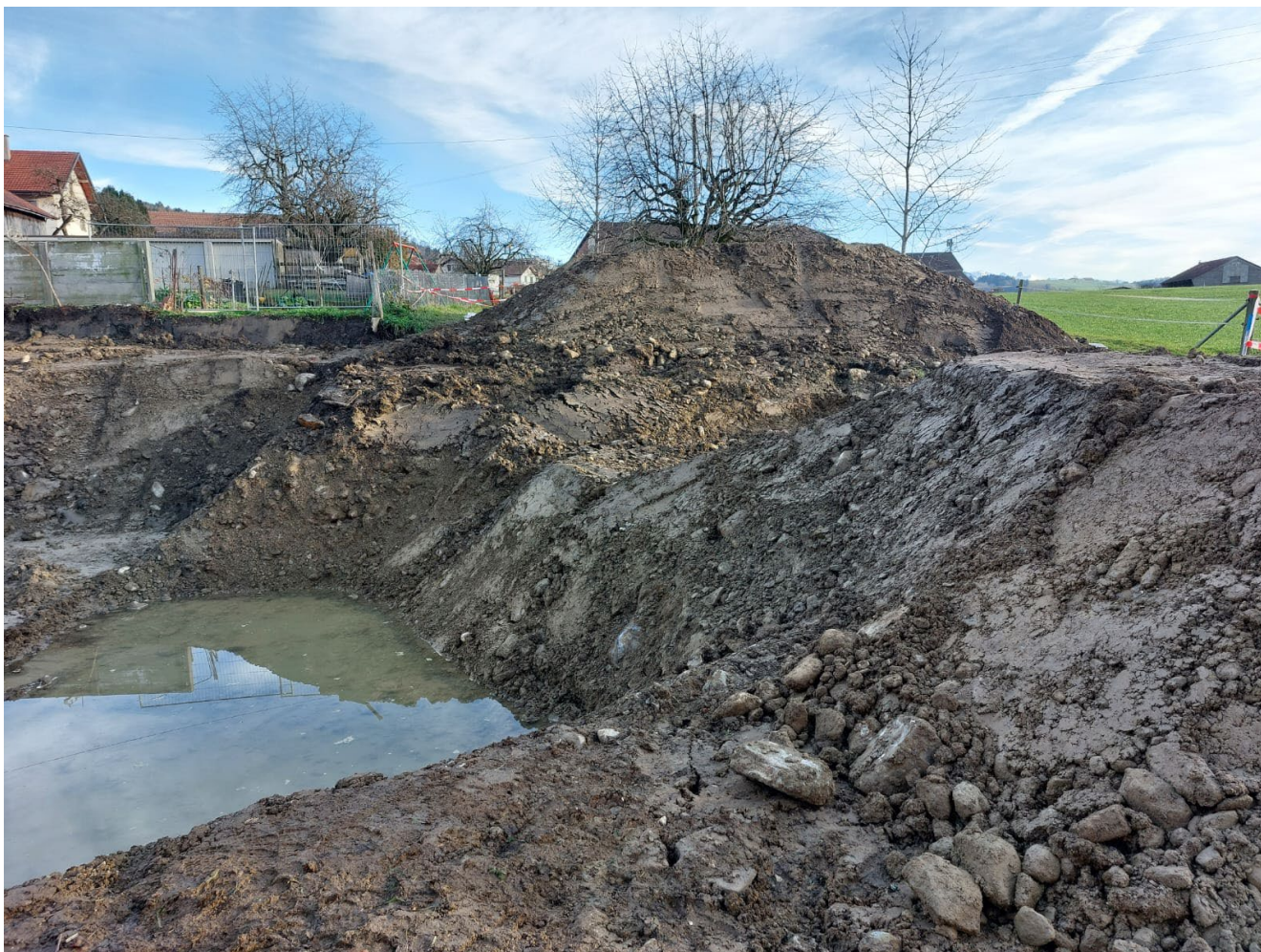
Le site de la laiterie d'Ursy en cours d'assainissement. © SEn
