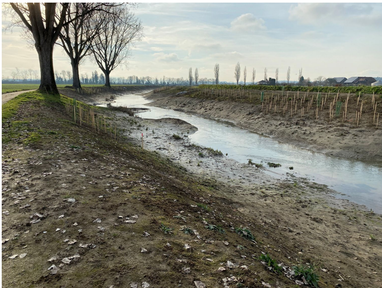
Revitalisation de la Petite Glâne, vue étape 3 – secteur amont, le 11 décembre 2025. © SEn
