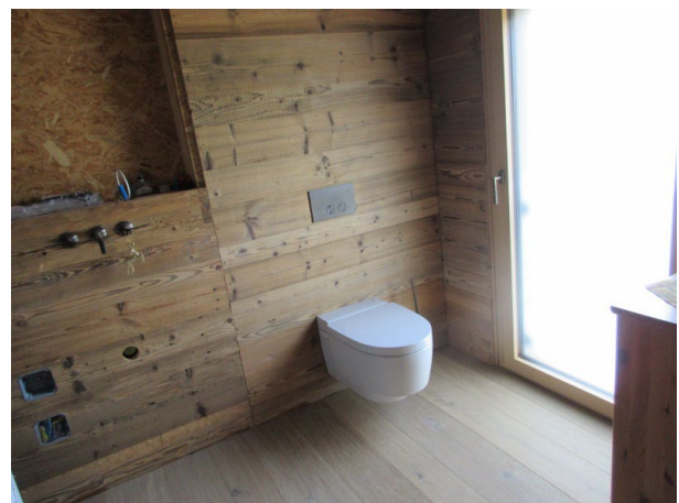
Salle de douche à terminer
