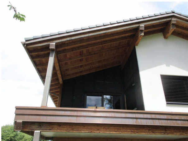
Balcon lot 2 à terminer
