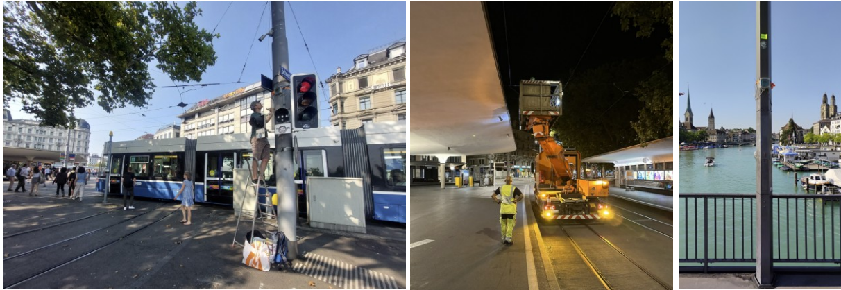
Abbildung 2: Impressionen der Sensormontage. Links: Montage von Sensor S12; Mitte: Verlegung der Verbindungskabel über den Fahrleitungen durch die VBZ; rechts: Sensor auf Brücken-Kandelaber
