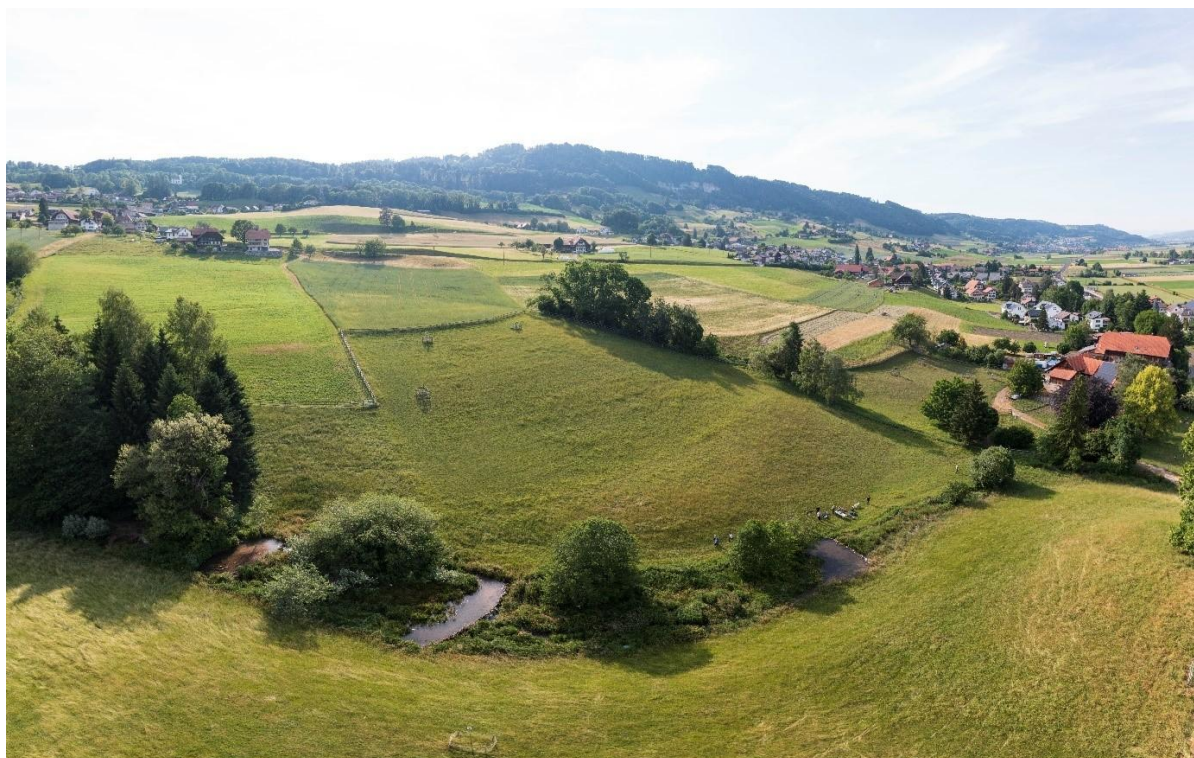
Abb. 26: Mehrere Beaver Dam Analogs an einem kleinen, ehemals tief eingeschnittenen Bach in Kaufdorf (BE). Vor dem Bau der BDAs sah der Bach aus wie unterhalb des letzten BDAs. Informationen zum Projekt in Minnig et al. (2024b) (Bild: Christof Angst).
