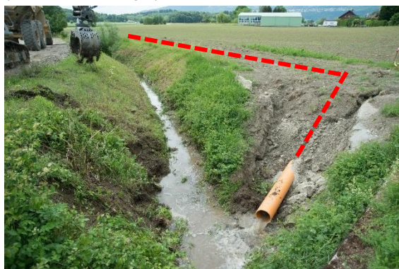
Abb. 27d: Ausfluss der Drainage-Sammelleitung in den Orpundbach. Unterhalb des Ausflusses dürfen keine Biberdämme entstehen. (Bild: Christof Angst)
