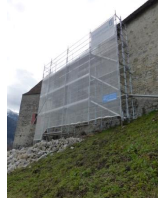
Abb. 1 Nördlicher Teil der Mauer – Umfang der Reparaturarbeiten
