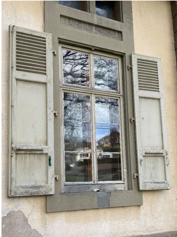
Photo n° 4: encadrement molasse de fenêtre à refaire, et joints amiantés. 1
