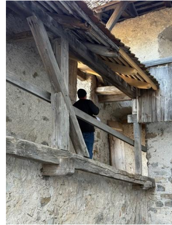
Figure 4 Chemin de ronde - Réparation d'urgence charpente
