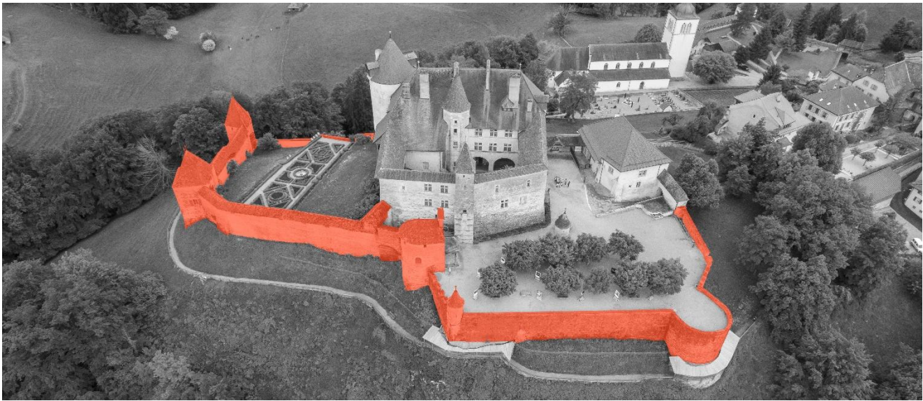
Abb. 12 Luftaufnahme der zu sanierenden Teile – Pasquier-Glasson SA
