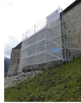
Figure 1 Mur Nord - Emprise des travaux de réparation
