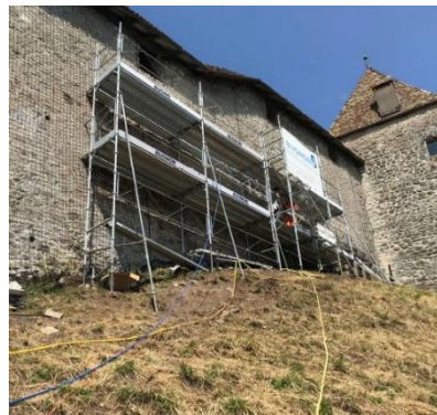
Figure 10 Mise en œuvre par « micro-clouage »
