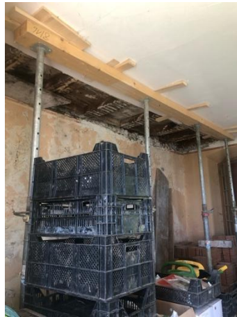
Abb. 5 Viereckiger Turm – Vorläufige Bodenabstützung
