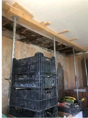
Figure 5 Tour carrée - Etayage provisoire du plancher
