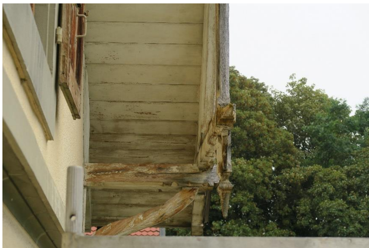
Photo n° 1: Charpentes détériorées 1
