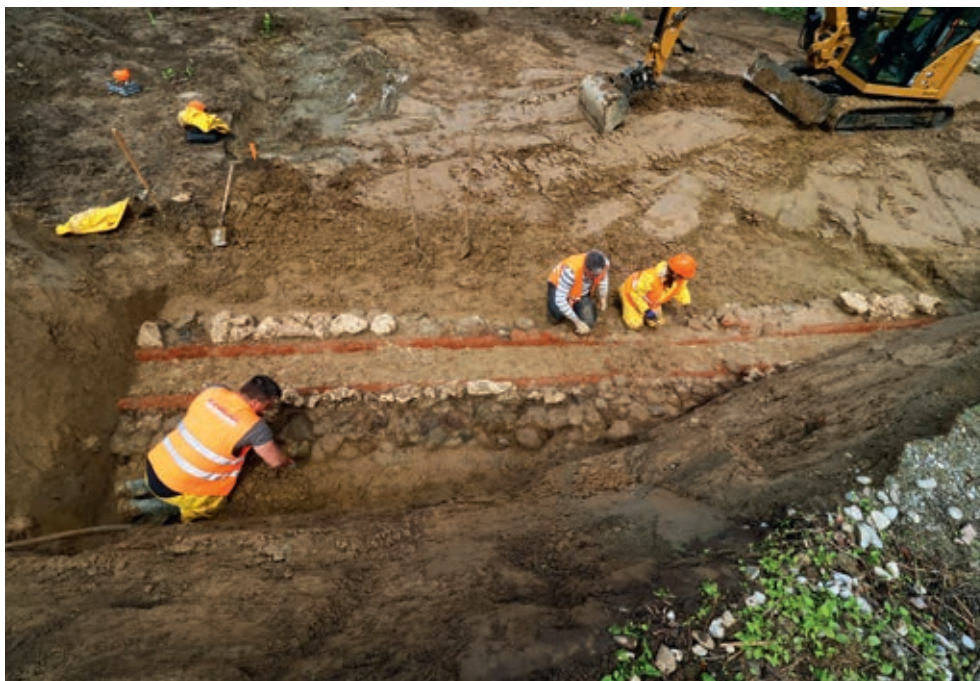
Fig. 22 Portion de l'aqueduc de Bonne Fontaine à Montagny-la-Ville.
