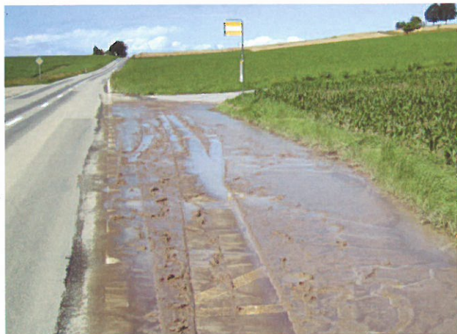
Durch Erosion verschmutzte Postautohaltestelle.
