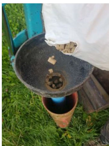
Beispiel für die Verfüllung eines Rohrs mit Bentonit
