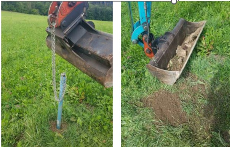
Entfernen eines Rohrs und Verfüllen des Aushubs
