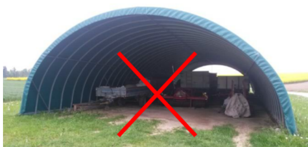
(a) Nicht im Kataster eingetragene Überdachung, keine Verankerung in Beton, Erdboden.
