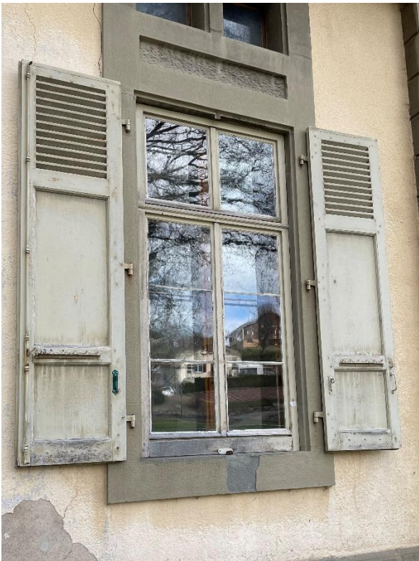
Foto Nr. 4: Verwitterter Fensterrahmen aus Sandstein, asbesthaltige Fugen
