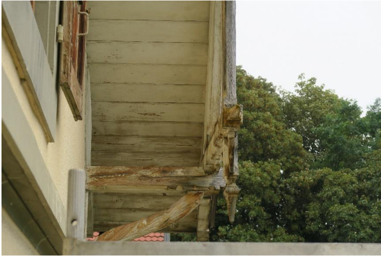
Foto Nr. 1: Beschädigte Traggerippe
