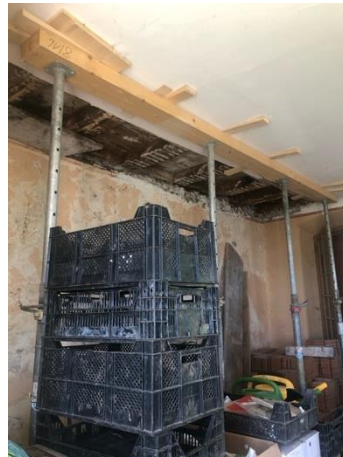
Abb. 5 Viereckiger Turm – Vorläufige Bodenabstützung
