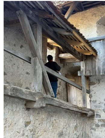
Abb. 4 Wehrgang – Notreparatur am Dachstuhl
