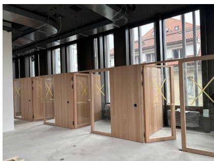
La construction des menuiseries se poursuit. © BO-A architectes
