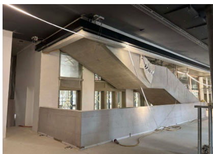
Le grand escalier public.
