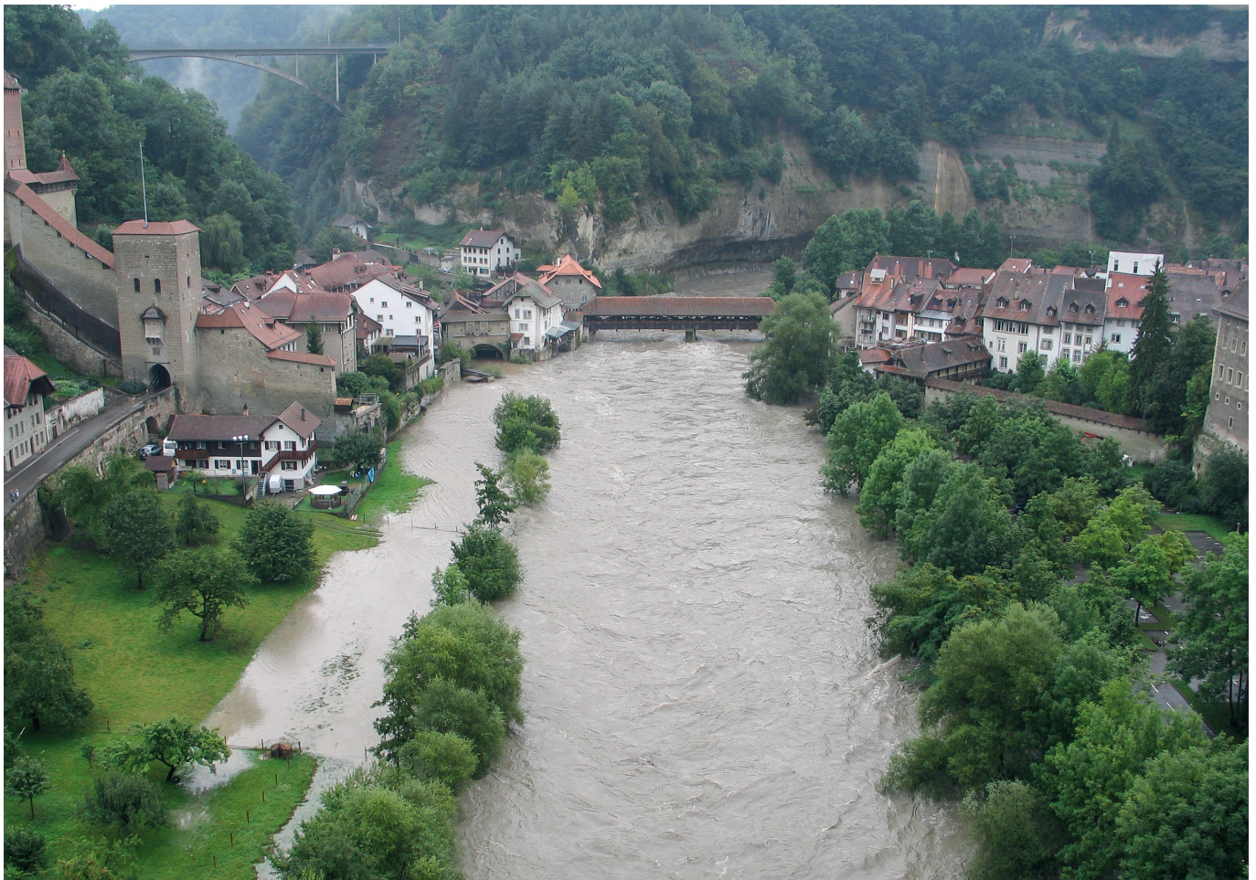
Die Saane in Freiburg mit Blick auf die Bernerbrücke während des Hochwassers im August 2005; In der Nacht des 14. Novembers 2023 wurden noch höhere Rekordwasserstände erreicht
