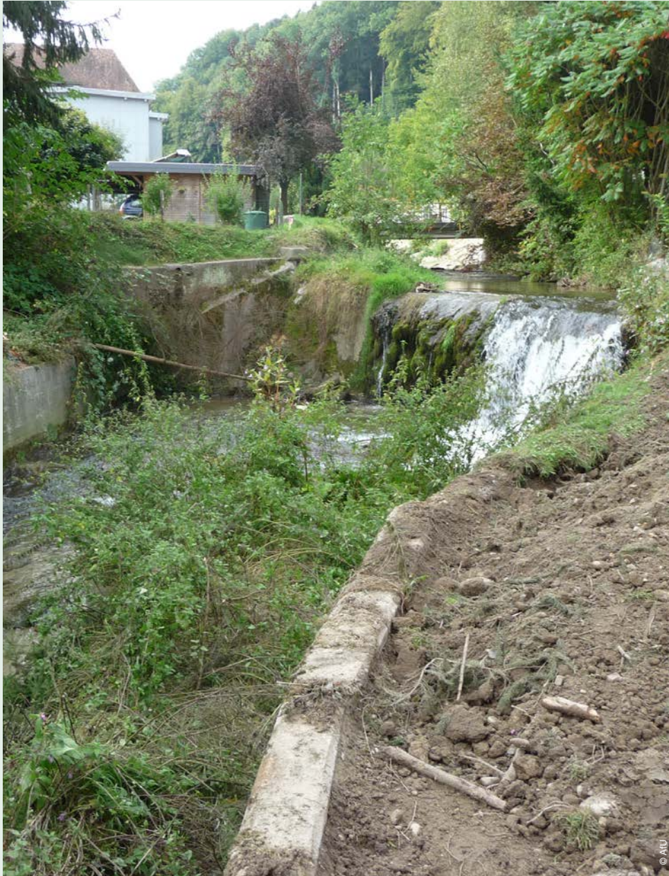
Eine der 3 sanierten Schwellen vor den Arbeiten.
