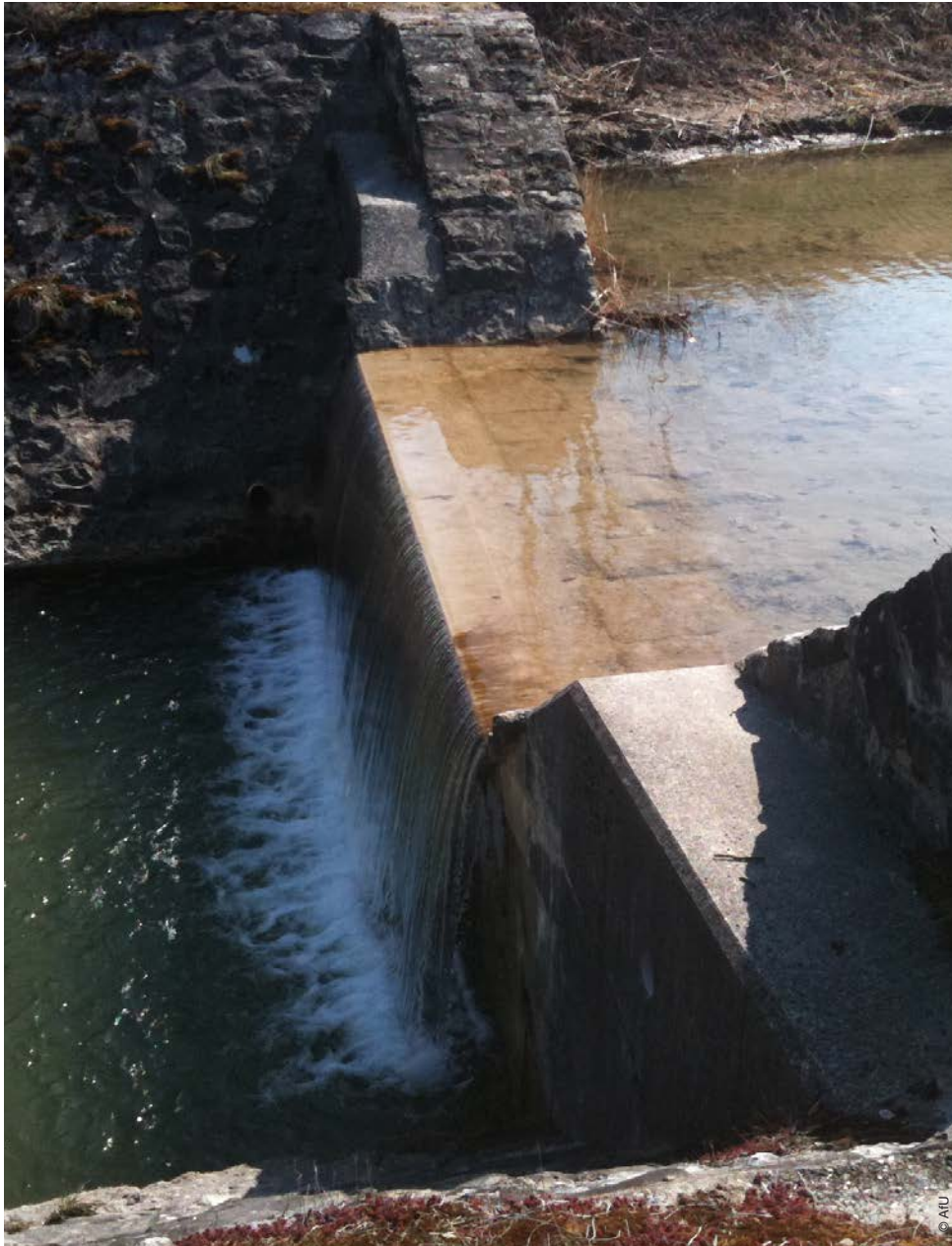
Die für Fische unüberwindbare Schwelle oberhalb der Kantonsstrasse.
