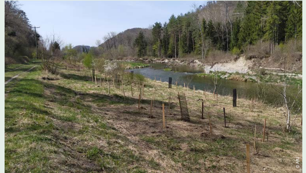
Begrünungsarbeiten im Jahr 2022. Anpflanzung von einheimischen Sträuchern und Bäumen in temporär gerodeten Bereichen und zur Beschattung des Fließgewässers.
