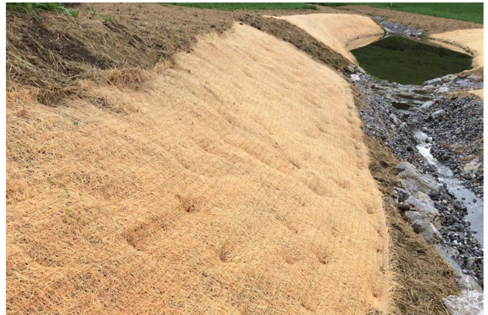
Testweise Einrichtung einer Erosionsschutzmatte aus Holzwolle als Alternative zur Kokosmatte.
