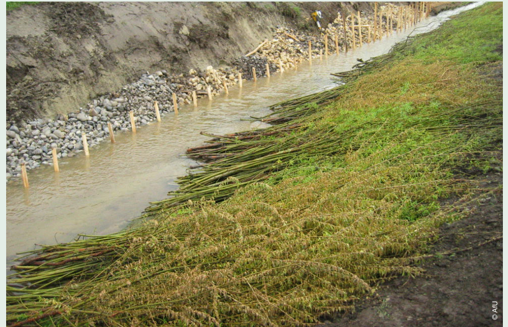
Einschlagen der Weiden im Hinblick auf die geplante Umpflanzung entlang der Ufer.
