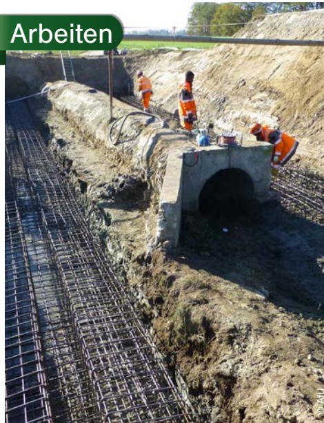
Einbau einer Halbschale, die der Fauna den Durchgang über das Fliessgewässer ermöglicht.
