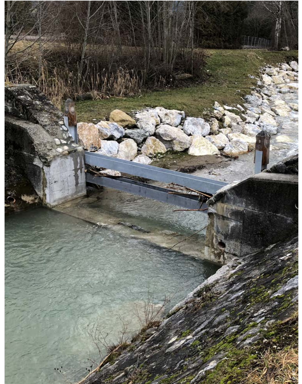
Nach den Arbeiten ist die Fischwanderung wieder möglich. Der Rechen hält bei Hochwasser das Schwemmgut zurück.
