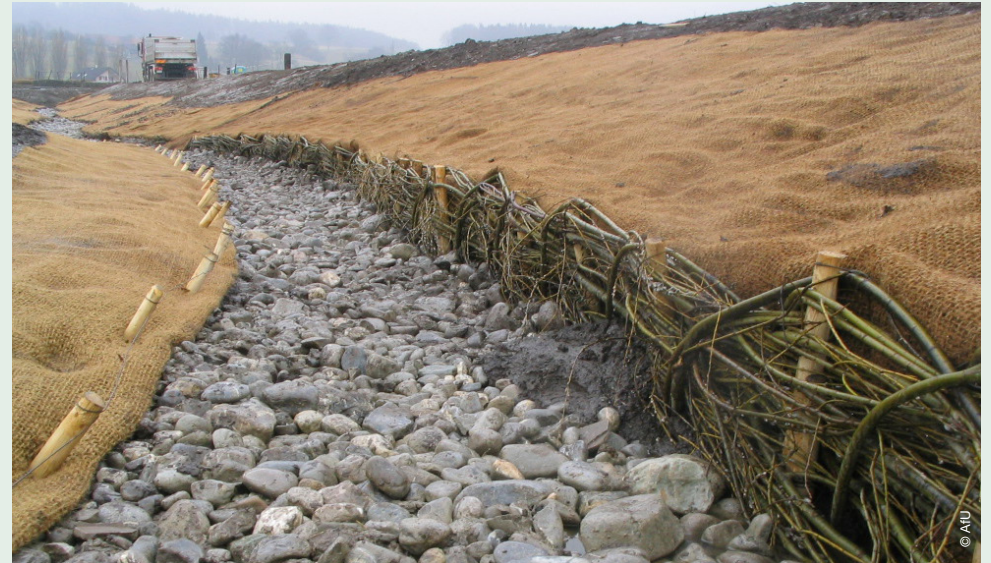
Einflechten der Weidenäste zur Stabilisierung der Ufer.
