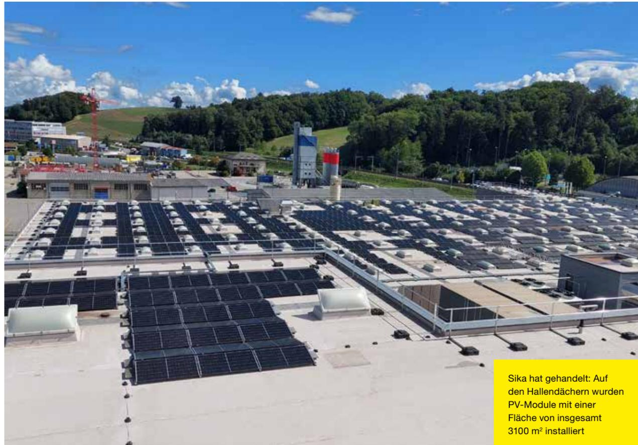
Sika hat gehandelt: Auf den Hallendächern wurden PV-Module mit einer Fläche von insgesamt 3100 m<sup>2</sup> installiert
