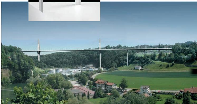
**Fonctionnel.** Partant du carrefour Saint-Barthélemy (côté Schoenberg), le pont de la Poya passe au-dessus de la Sarine et de la station d'épuration de la ville sur une longueur de 852 mètres, pour se prolonger par un tronçon souterrain (sous le parc du Palatinat, la route de Grandfey et la voie CFF) d'une longueur de 251 mètres et pour déboucher sur l'actuel carrefour de Saint-Léonard qui sera réaménagé.
