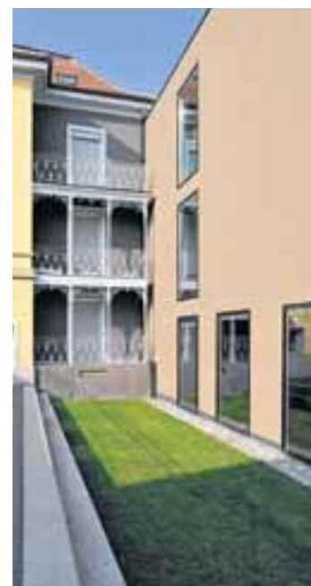
Minergie-Gebäude (r.) sind heute gefragt. Bild Charles Ellena
