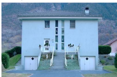
Escalier sans importance, aucun de ses murs latéraux n'est à lever
