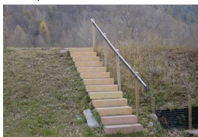
Escalier sur le terrain, sans importance
