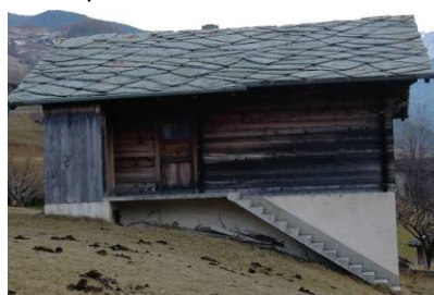
Escalier extérieur qui n'est pas sur cave / sans importance
