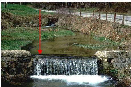
Les collecteurs de gravier sont à lever, le niveau le plus élevé de la retenue (arête du déversoir) définissant la limite des eaux.
