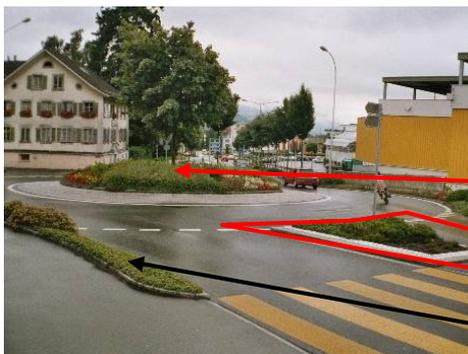
La route englobe également la surface pavée (car elle peut être empruntée par des bus articulés ou des semi-remorques).
