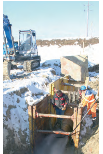
Ein kräftiger Wasserstrahl reinigt die Kanalisation
