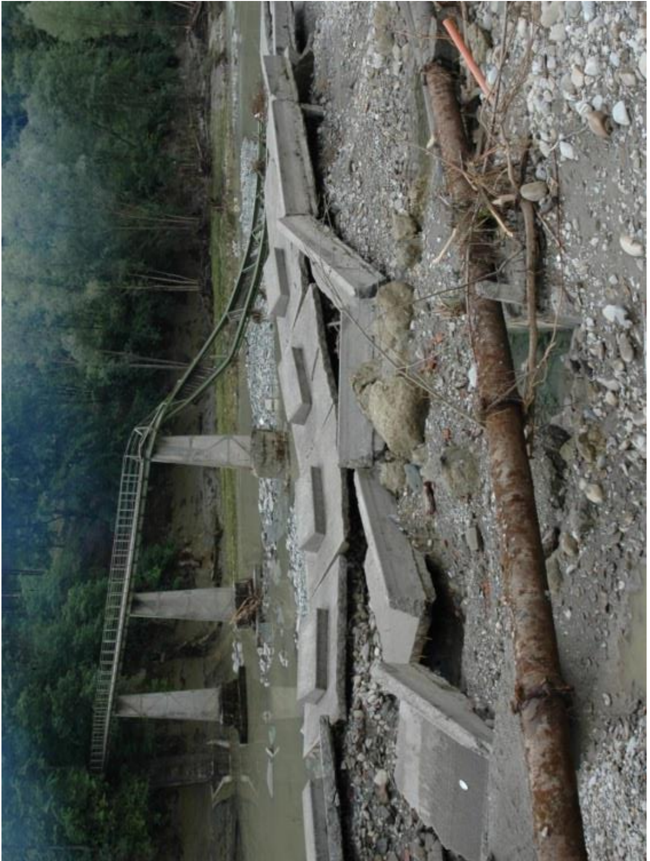
Hochwasserschäden bei der Staumauer der Magerau © AfU
