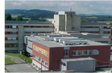
Hôpital intercantonal de la Broye - Payerne
