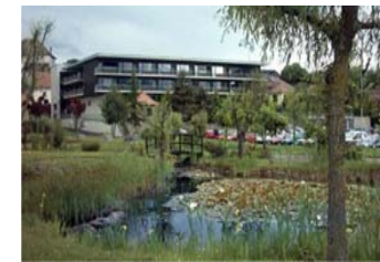
Hôpital intercantonal de la Broye – Estavayer-le-Lac
