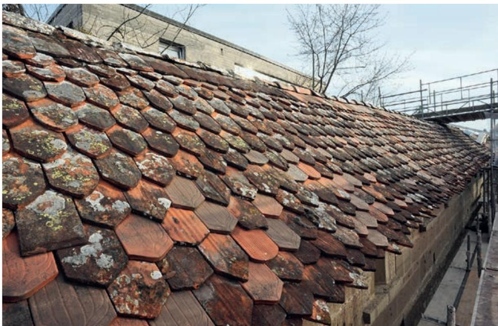
**Fig. 65** Détail de la couverture de l'enceinte avant restauration, avec son mélange de tuiles utilisées entre le XV<sup>e</sup> et le XX<sup>e</sup> siècle
