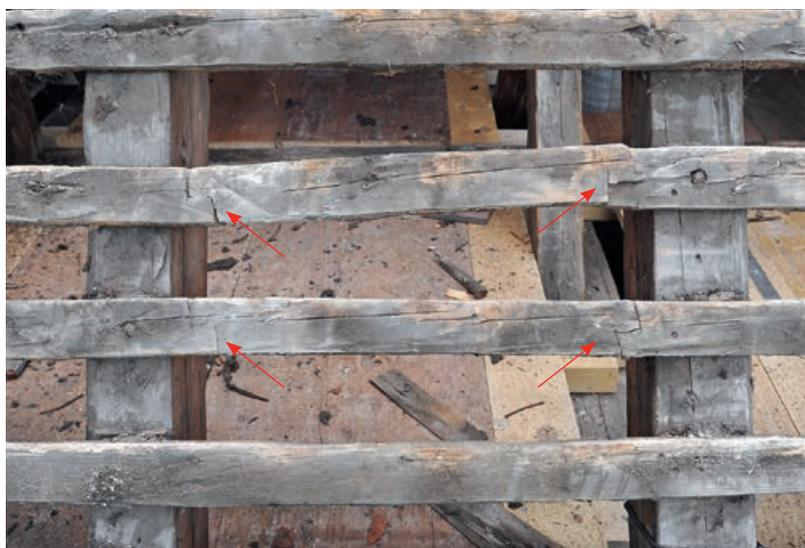
Fig. 21 Tour des Chats, péclouse dans le lattage d'origine (1424/1425) avec indication des découpes effectuées sur les lattes amovibles (flèches)
