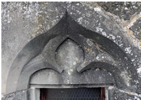
Fig. 16 Tour Rouge, face sud, détail du linteau de l'une des fenêtres du quatrième niveau avec son motif de remplages aveugles surmonté d'une accolade
