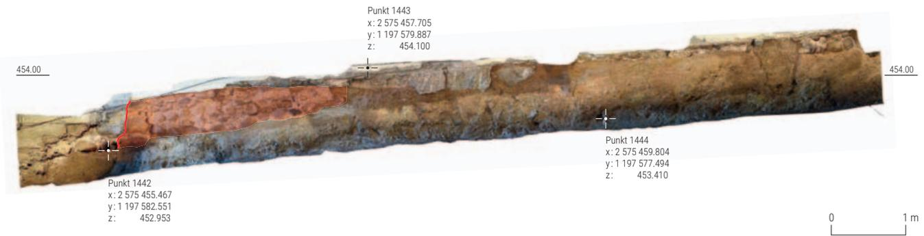
**Abb. 19** Leitungssanierungen in der Murtener Altstadt 2014: Orthophoto des Ostprofils mit den mittelalterlichen Mauerresten (rot eingefärbt) im Durchgang beim Rathaus
