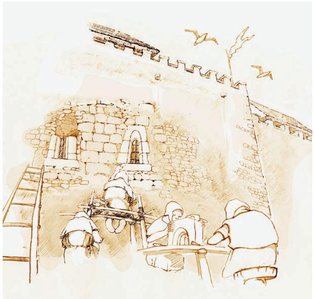
**Abb. 10** Im Bereich des Kronenkellers werden Lichtscharten in die Stadtmauer eingebaut. Blick von aussen an die Stadtmauer
