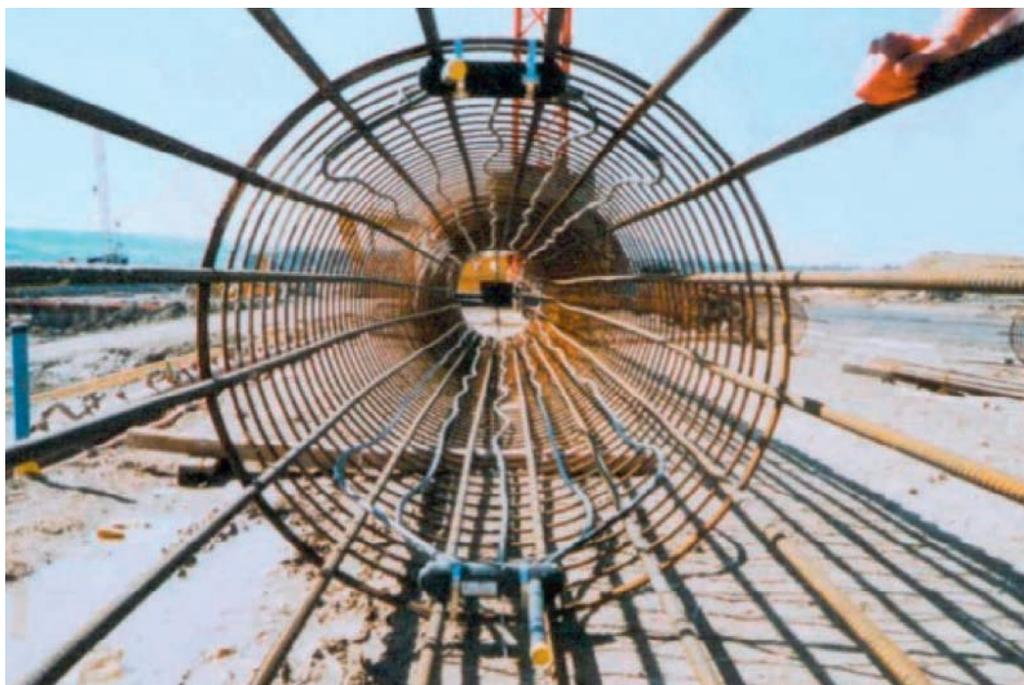
Conduites de circulation de fluide caloporteur fixées à la cage d'armature d'un pieu moulé. Source: [3]
