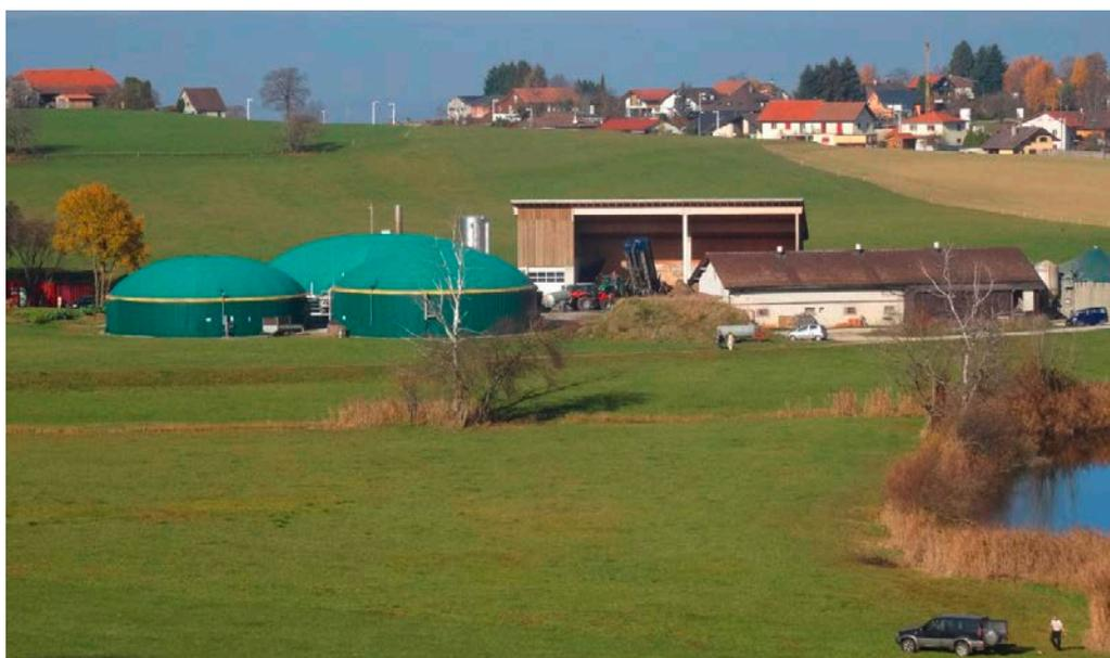
Le système couplage chaleur-force installé au Mouret sur le territoire de la commune de Ferpicloz est doté d'une puissance électrique de 280 kW et d'une puissance thermique de 344 kW. Il produit environ 2,1 GWh de courant et 2,6 GWh de chaleur par année. La centrale à biogaz valorise les lisiers et fumiers provenant d'une vingtaine d'exploitations agricoles des environs ainsi que des déchets organiques communaux. Source: Marcel Gutschner
