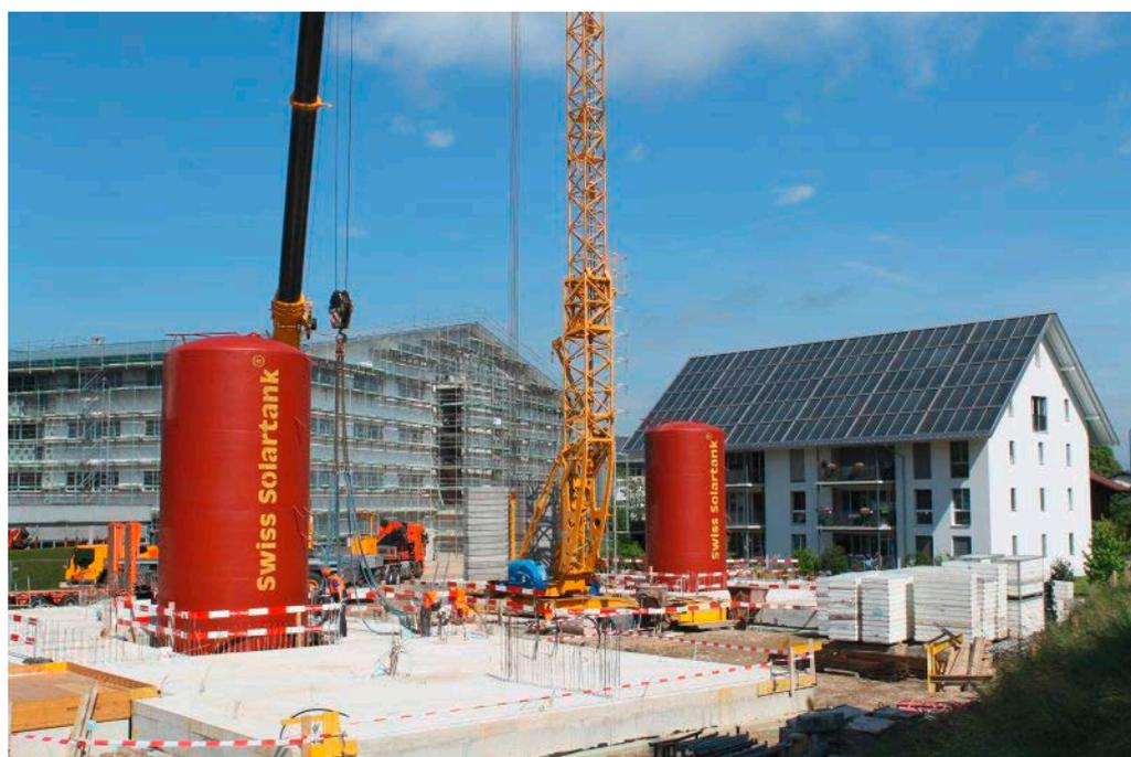
Construction de nouvelles maisons chauffées 100% au solaire, les accumulateurs pour stocker l'eau chaude sont posés en début des travaux. Source: Jenni Energietechnik
