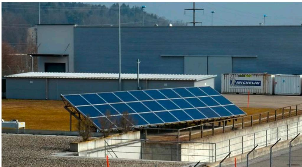
Installation photovoltaïque pour l'électrolyse et la production d'hydrogène à Givisiez. Source: Marcel Gutschner
