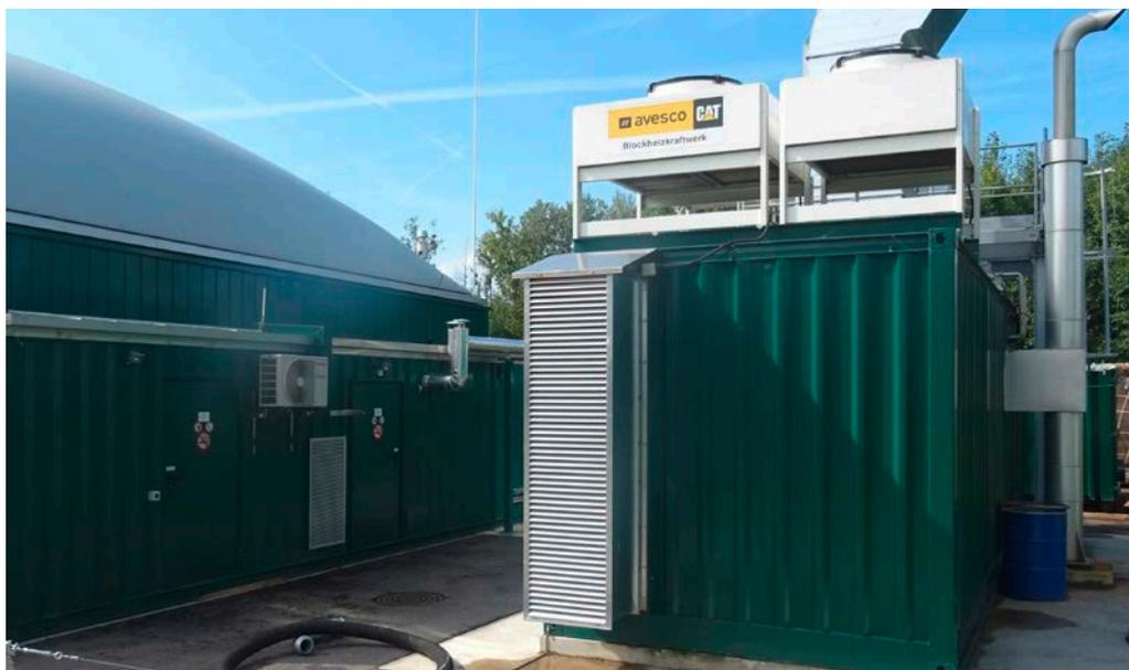
Système de couplage chaleur-force d'une puissance de 150 kW électrique sur le site de l'installation de biogaz de la Kompostieranlage Seeland SA, sur le territoire de la commune de Charmey (Lac) / Galmiz. Le méthane d'environ 4'500 tonnes de déchets verts est valorisé dans le système pour produire environ 760 MWh de courant et 730 MWh de chaleur. Source: Marcel Gutschner
