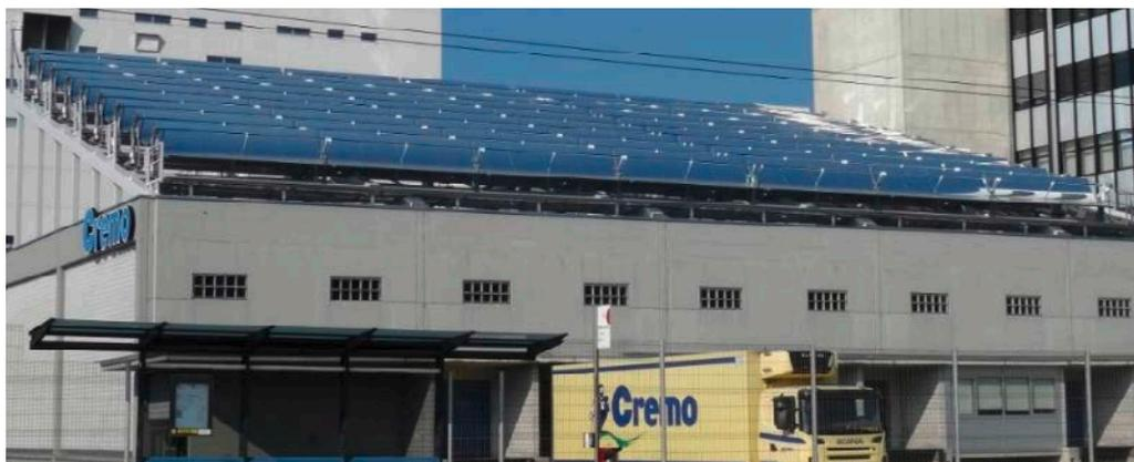
Ce site fabriquant des produits laitiers à Villars-sur-Glâne dispose d'une installation de 580 m<sup>2</sup> de capteurs à concentration. Ils servent à produire de l'eau à 150 C° pour la stérilisation de crème. Source : Marcel Gutschner
