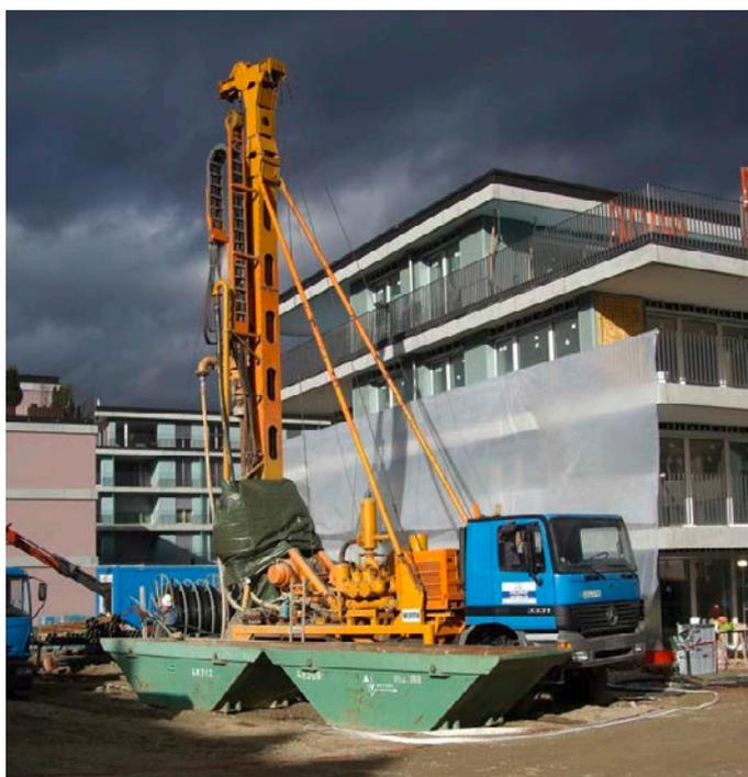
Forage pour une sonde géothermique verticale. Source : GEOTHERMIE.CH
