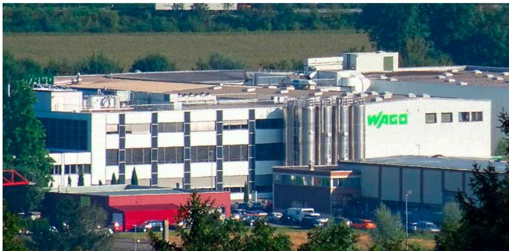
L'entreprise Wago a réalisé de nombreuses mesures d'efficacité énergétique dans les procédés industriels sur son site de production à Domdidier [20]. Lors de l'assainissement des façades, des modules photovoltaïques ont été intégrés dans le bâtiment. Source : Marcel Gutschner
