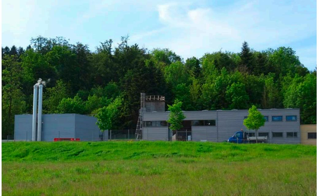
La centrale du CAD à Corminboeuf dotée d'une chaudière à bois de 900 kW assurant au minimum 80% de la production de chaleur et une chaudière à gaz de 1050 kW qui sert de solution de secours ou d'appoint lors de grands froids. Les deux bâtiments (centrale CAD et édilitaire) sont équipés de deux installations photovoltaïques de 17 resp. 38 kW. Source : Marcel Gutschner
