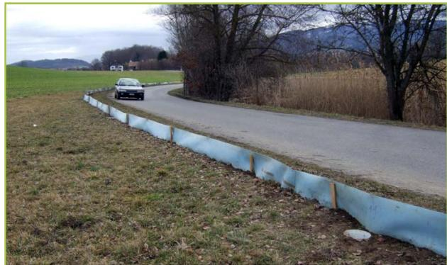
Abb. 1 Schutzzaun bei der Kantonsstrasse Magnedens-Posat
